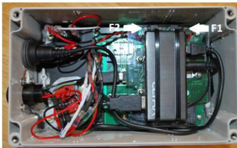
Figure 4 ITI Internal View
